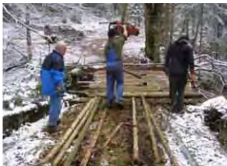
Popravljanje mostu, foto Alenka Hitti
