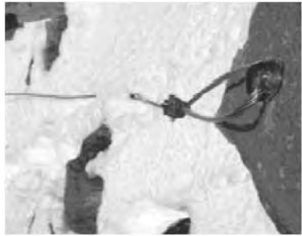
Slika 42: pretanka jeklenica; premalo spojk za jeklenico, zanka jeklenice brez notranjega vložka; standardni svedrovci so sicer dovoljeni, vendar bi bilo pravo sidro veliko bolj primerno.
