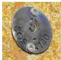
Slika 29: Označevalna ploščica s številko odseka
