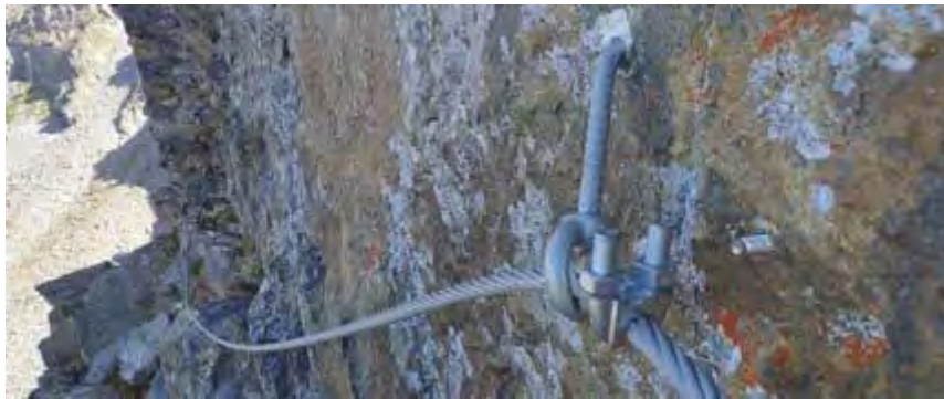
Slika 37: glej komentar pod sliko 36. Dolžina in debelina sidra kot način pritrjevanja so neustrezni.
