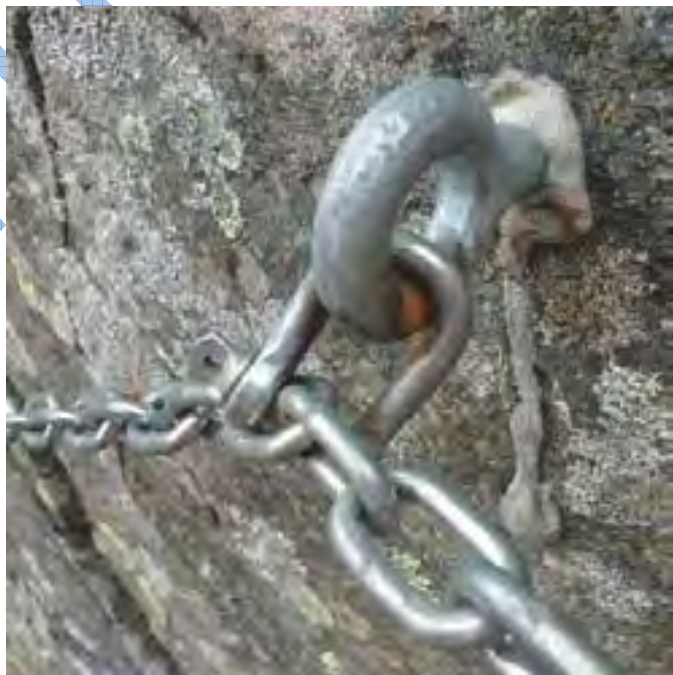
Slika 54: vsaka veriga je tako močna kot je njen najšibkejši člen; ta način varovanja (namesto jeklenice) ni optimalen (še sprejemljiv), vendar naj ne bo v nobenem primeru uporabljen v zavarovanih plezalnih poteh! Vijačni sistem naj bo vedno fiksiran!
