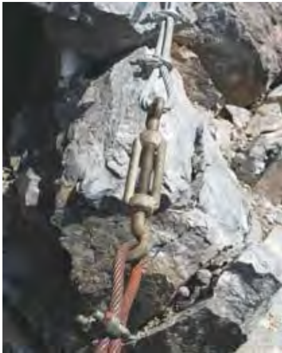
Slika 51: odprt napenjalni sistem v varovalni verigi
