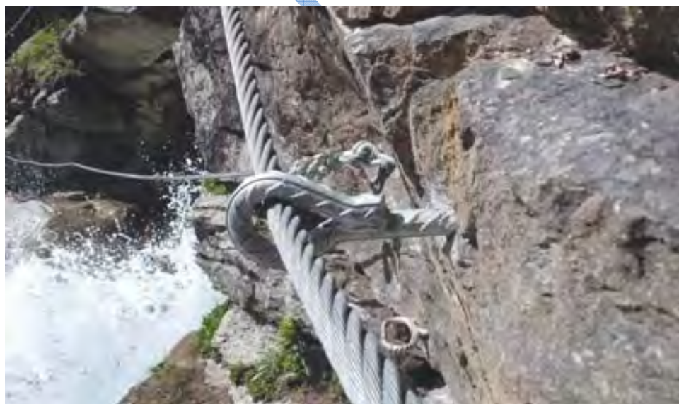
Slika 30: Vmesno očesno sidro iz prednapetega jekla z močno prednapeto jeklenico (notranja stran očesa je gladka in brez robov)
