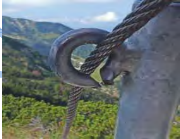
Slika 44: sistem sidranja z očesnimi sidri in preslabo napeto jeklenico, ki je nevarno poškodovala oko sidra
