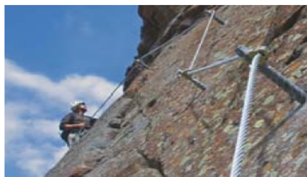
Slika 35: dobro stanje sider, poravnana – blago napeta jeklenica, dober izbor smeri poti, uporaba naravnih stop in oprimkov
