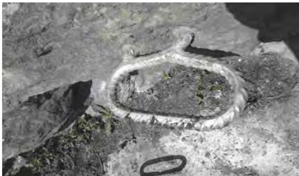
Slika 26: Stopno krožno pomagalo iz obstojnega jekla (vroče cinkano) ne vsebuje ostrih robov. V primeru stopanja na rob ne pride do zasuka pomagala.
