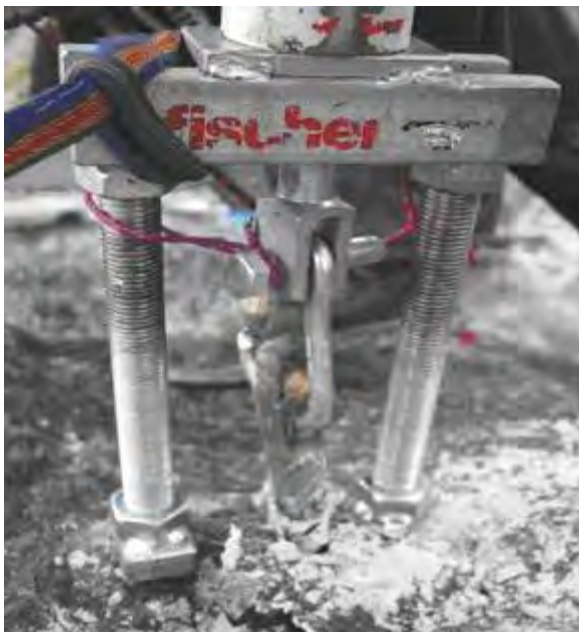
Slika 16: izvlek sidra v njegovi osi s hidravliko
