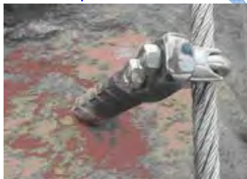
Slika 34: masivno, ploščato-kovano sidro namenjeno prečnim obremenitvam
