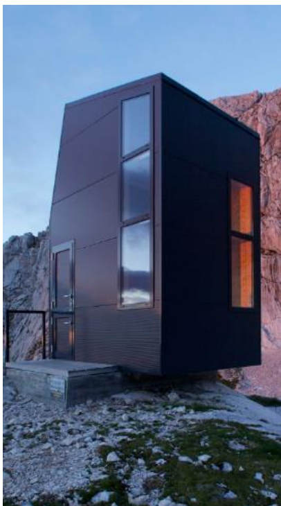
Bivak pod Grintovcem Arhitekt Miha Kajzelj 2009
