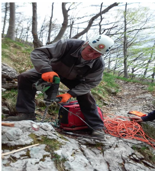
NAMESTITEV OPRIJEMNEGA KLINA
