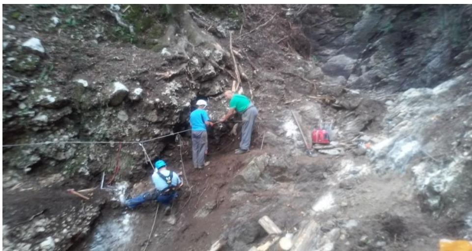
NAMESTITEV JEKLENICE
