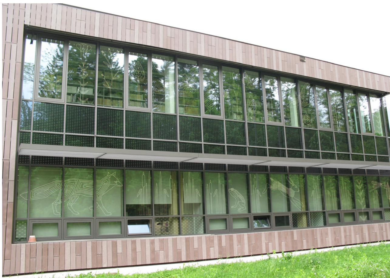
Montaža nalepk na stavbo, Z in J stran. Foto: Polonca Peterca
