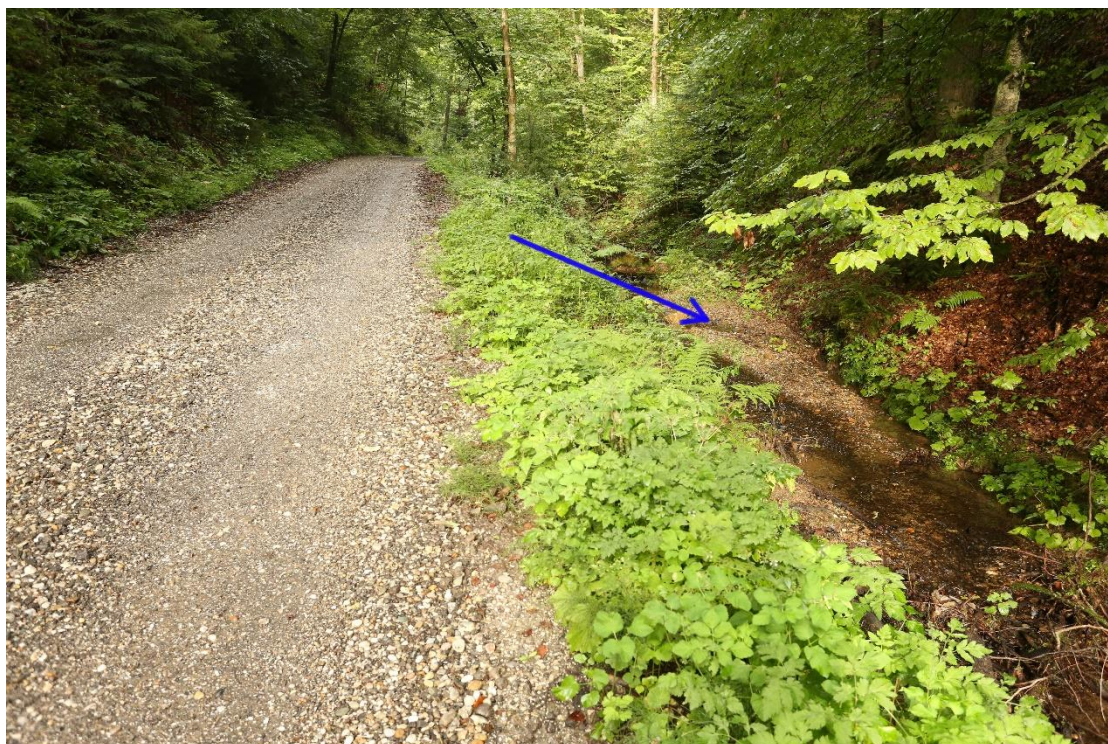
Slika 10. Primer dviganja nivoja dna struge, kot posledica nanosa peščenega materiala iz makadamskega cestišča ob večjih nalivih (označeno z modro puščico). Opomba: Fotografija je nastala po deževju, ko naj bi bilo vode v potoku veliko, na fotografiji je globina približno 5 centimetrov. Foto: Daniel Jehart
