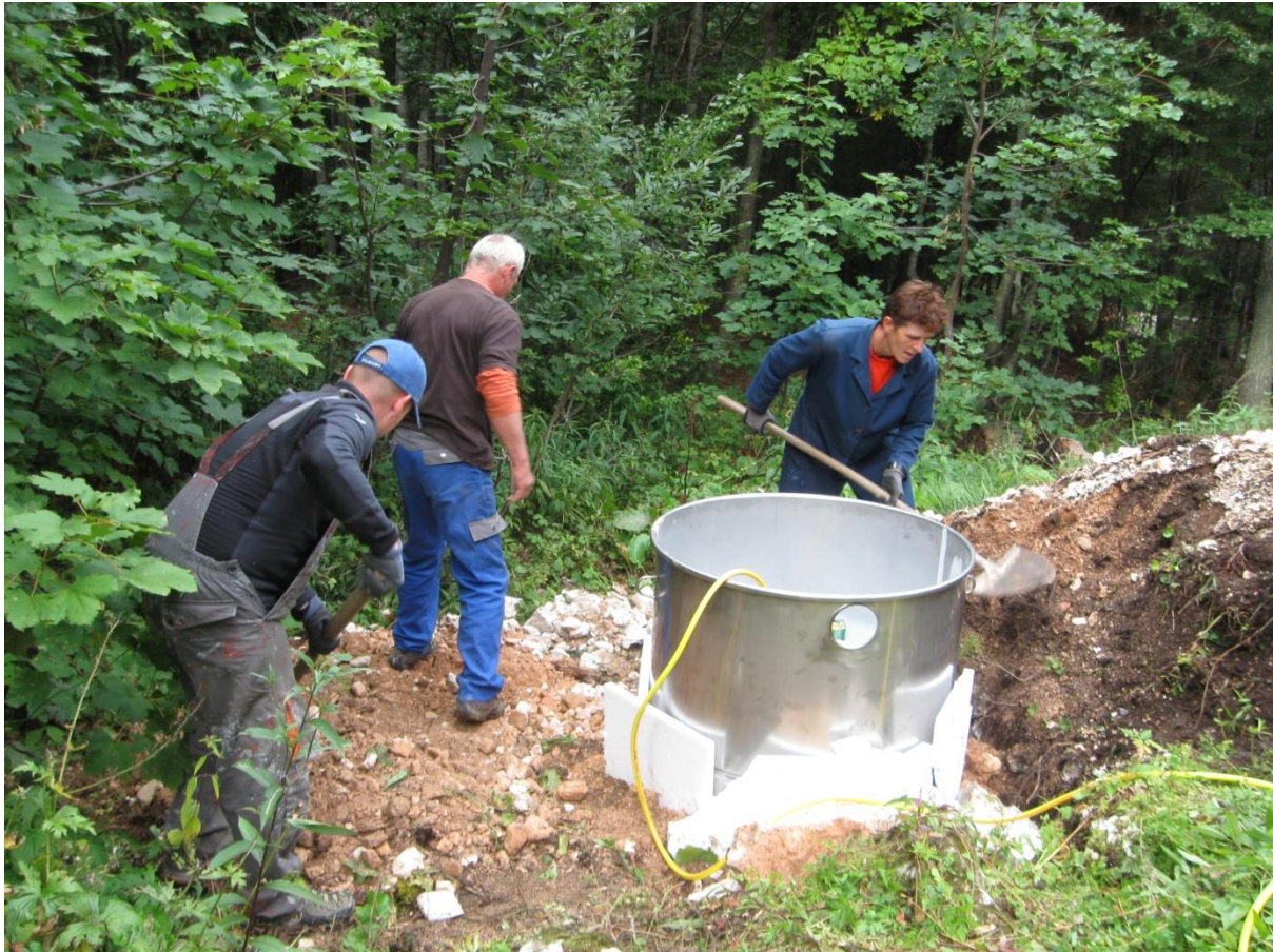
Slika 9: Vgradnja biološke čistilne naprave
