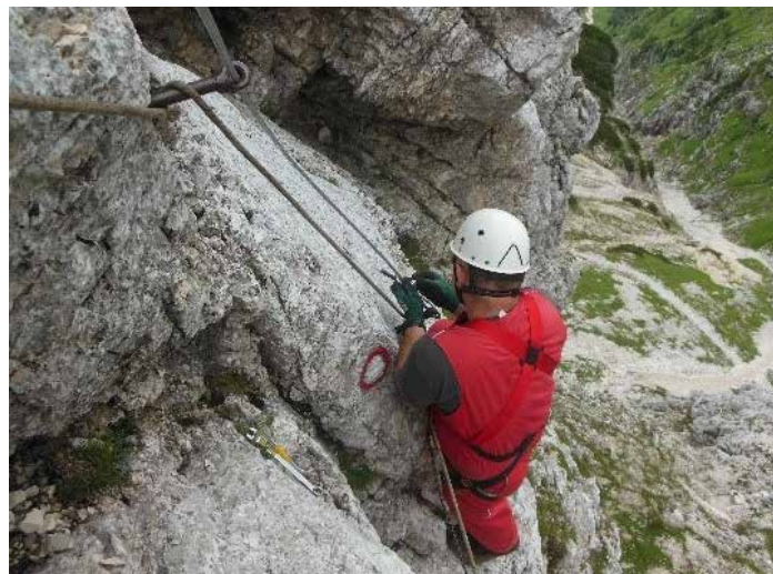
Vgradnja jeklenice. Foto Edo Tomšič
