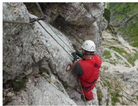
Vgradnja jeklenice na poti prek Plemenic (Foto:Edo Tomšič)
